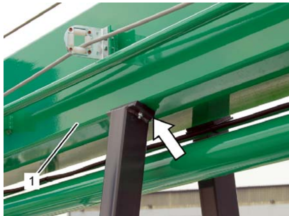
Abb. 43: Lage Teleskopmast prüfen
